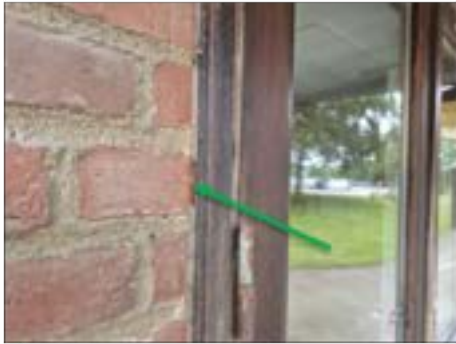
✓ V:5. Vid dörr. Träkarm/tegel. Fog brun mjuk/elastisk. PCB-halt: 29,0 mg/kg. Bly halt: <1 mg/kg. Ej asbest. Ej klorparaffiner.
