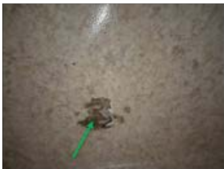
✓ 11031:2 Svartlim under synlig golvplastmatta. Ej asbest.
