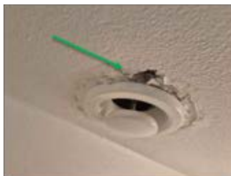
✓ 09006:3. Tätning kring vent.don. Grå + vit. Ej asbest.
