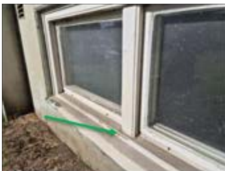
✓ Ö:12. Underkant fönster. Fönsterkarm/plåt. Kitt grått tunt. Ej asbest.
