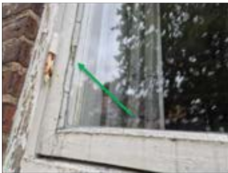
✓ V:3. Fönster. Kitt vitt hårt. Ej asbest.
