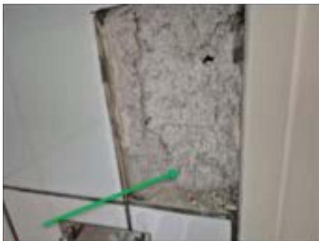
✓ 10027:2 + 10025:1. Vitt kakel. Fix & fog. Ej asbest.
