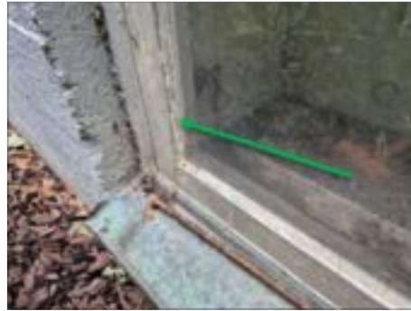
✓ N:3. Fönster. Kitt beige hårt. Ej asbest.
