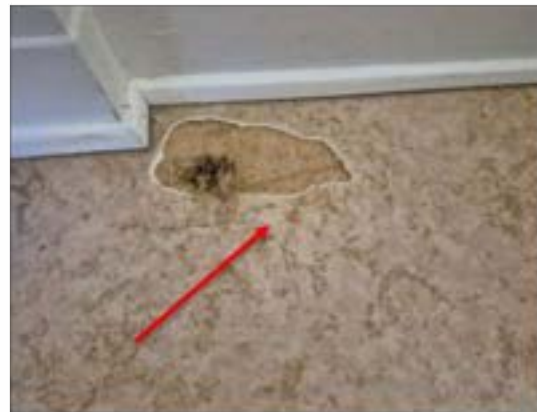
✖ 11002:1. Golvplastmatta brunmelerad, ljus. Ovan spånskiva.
