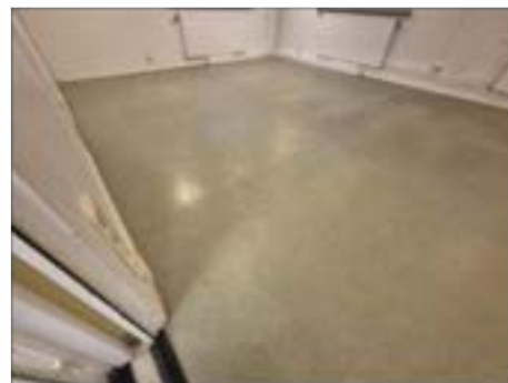
✖ Exempelbild golvplastmatta by 112 plan 09. Antas innehålla mjukgörare så som prov 10017:1 och 11002:1. Hanteras som farligt avfall om inte kompletterande provtagning visar annat.
