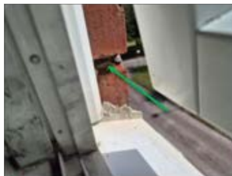
✓ S:5. Vid fönster. Mellan tegel och fönsterplåt. Fog brun mjuk. Ej asbest.
