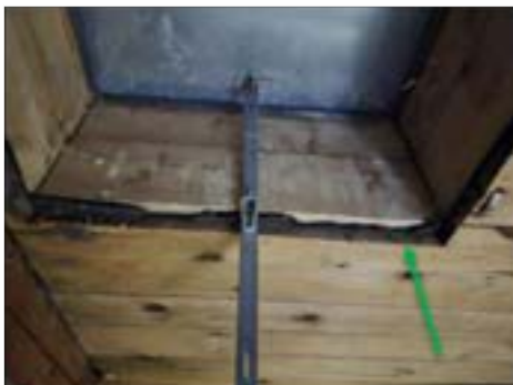
✓ Vind Takpapp, undre lagret. Vid taklucka. Ej PAH.
