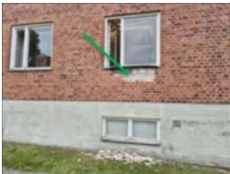
✓ Cellplastisolering bakom tegel. Ej freon.
