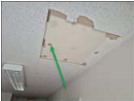
✓ 12002:1. Punktlim under akustikplatta. Lim gulbrunt. Ej asbest.
