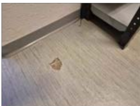
✓ 10044:1. Golvplastmatta grönstrimmig + mörkbrunt lim. Ej asbest.
