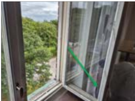
✓ Ö:10. Fönster. Kitt vitt hårt. Ej asbest.
