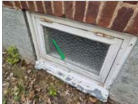
✓ Ö:9. Fönster. Kitt vitt hårt. Ej asbest.
