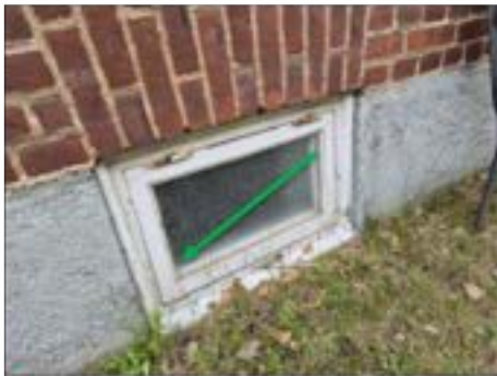
✓ N:4 + Ö:8. Fönster. Kitt vitt fast. Ej asbest.
