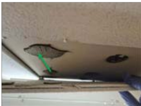
✓ 09004:1. Punktlim under äldre akustikplatta. Lim mörkbrunt. Ej asbest.
