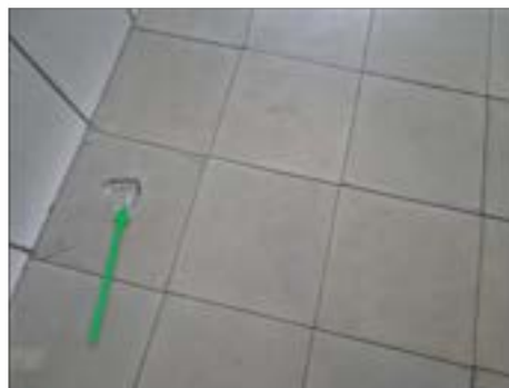
✓ 09008:1 Fix och fog vid beige klinker. Ej asbest.
