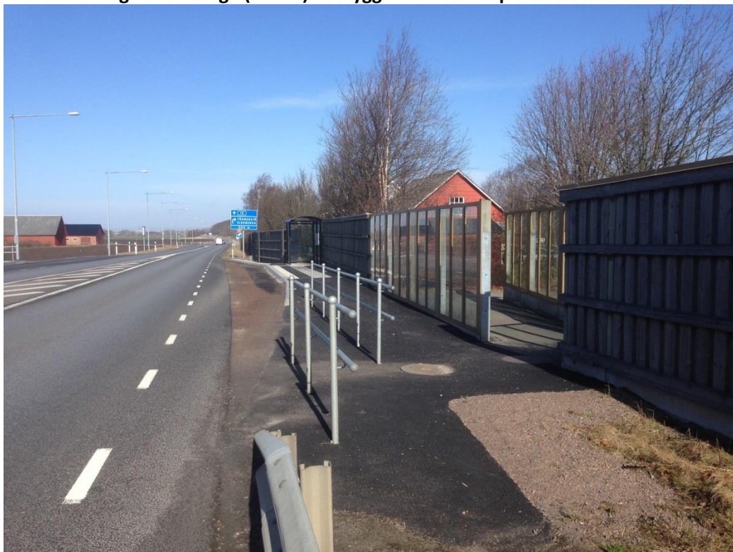
Gullbrannavägen Eldsberga (EFTER) ombyggnation av hållplats
