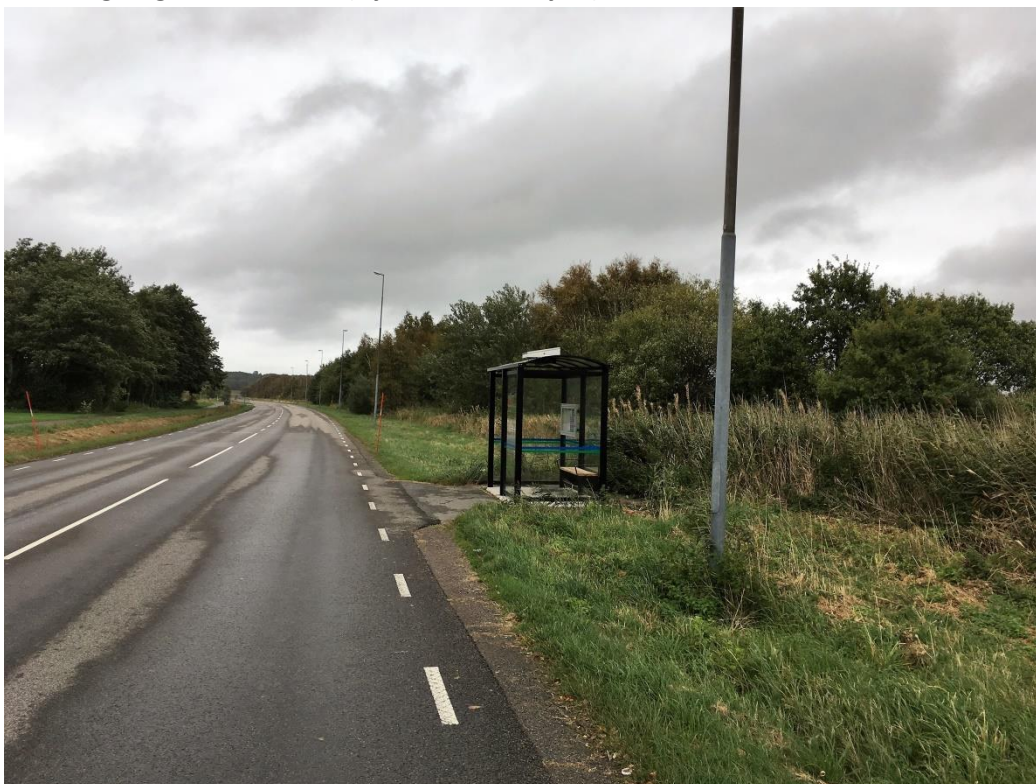
Videbergsvägen Bua, EFTER (byte av väderskydd)
