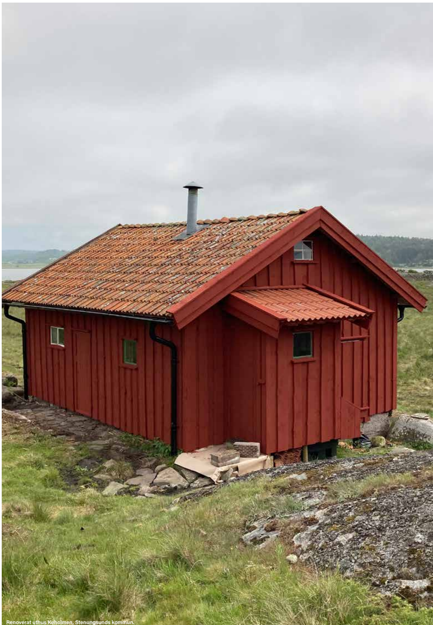
Renoverat uthus Keholmen, Stenungsunds kommun.
