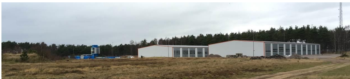
Industribyggnader på fastighet Mellby 23:22, som ligger i planområdets nordvästra hörn.
