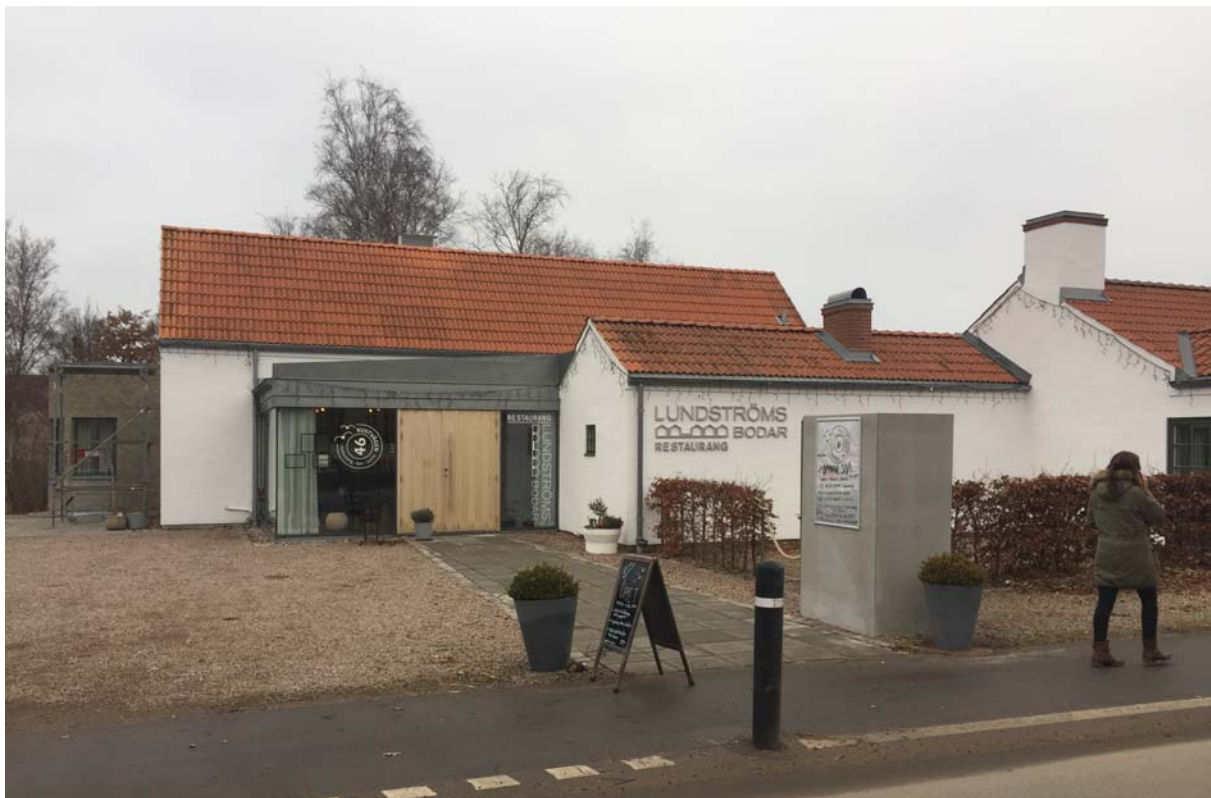
Handelsbodarna vid Rombergs väg.
