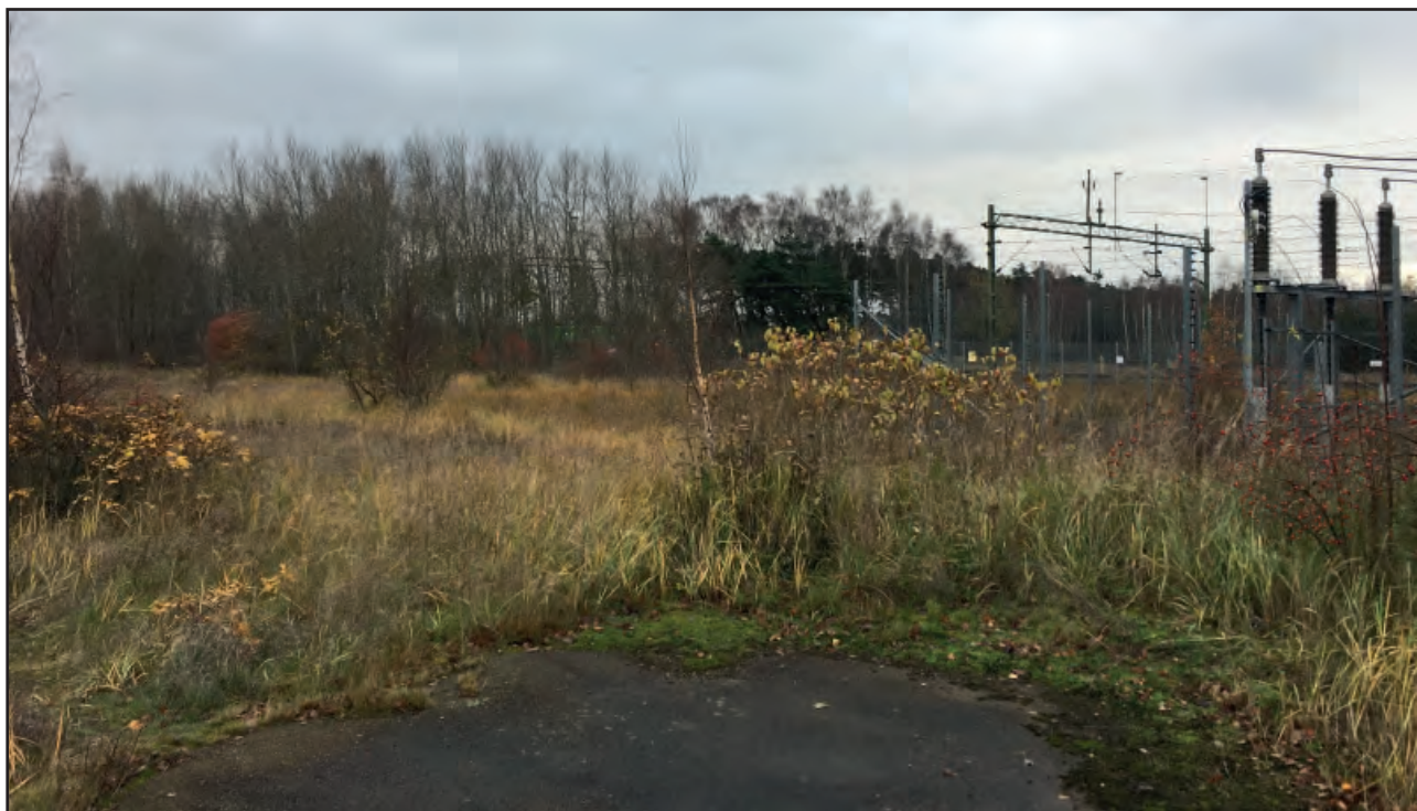
Bild 8. Norra delen av planområdet och objekt 4. Ställverket skymtas till höger i bild.
