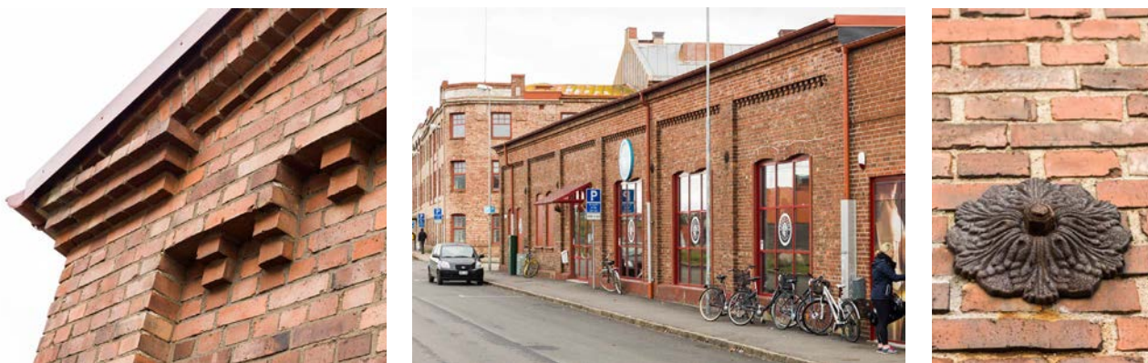
Bild 12: Befintlig snickeriverkstad med fasad och byggnadsdetaljer.
