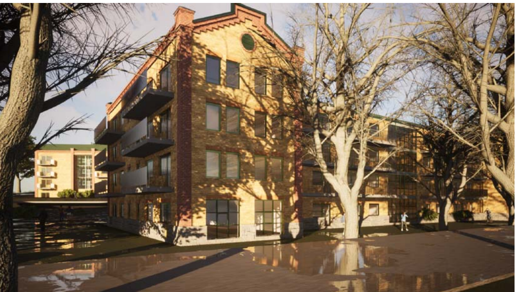
Hus A, mot Allégatan och hus B i bakgrunden.
