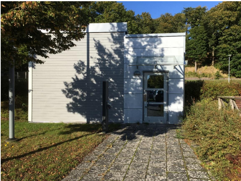
Bild 2, Byggnad B142, Entré med trappa och hiss till kulvert.
