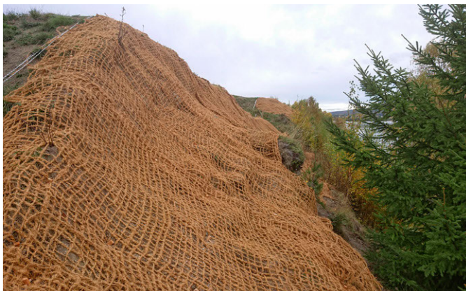
Kokosfibrer och insådda gräsfrön ska hjälpa till att skapa ett varaktigt växttäck som hindrar fortsatt erosion av lämningarna efter fogdeborgen. Foto: Västernorrlands Museum.
