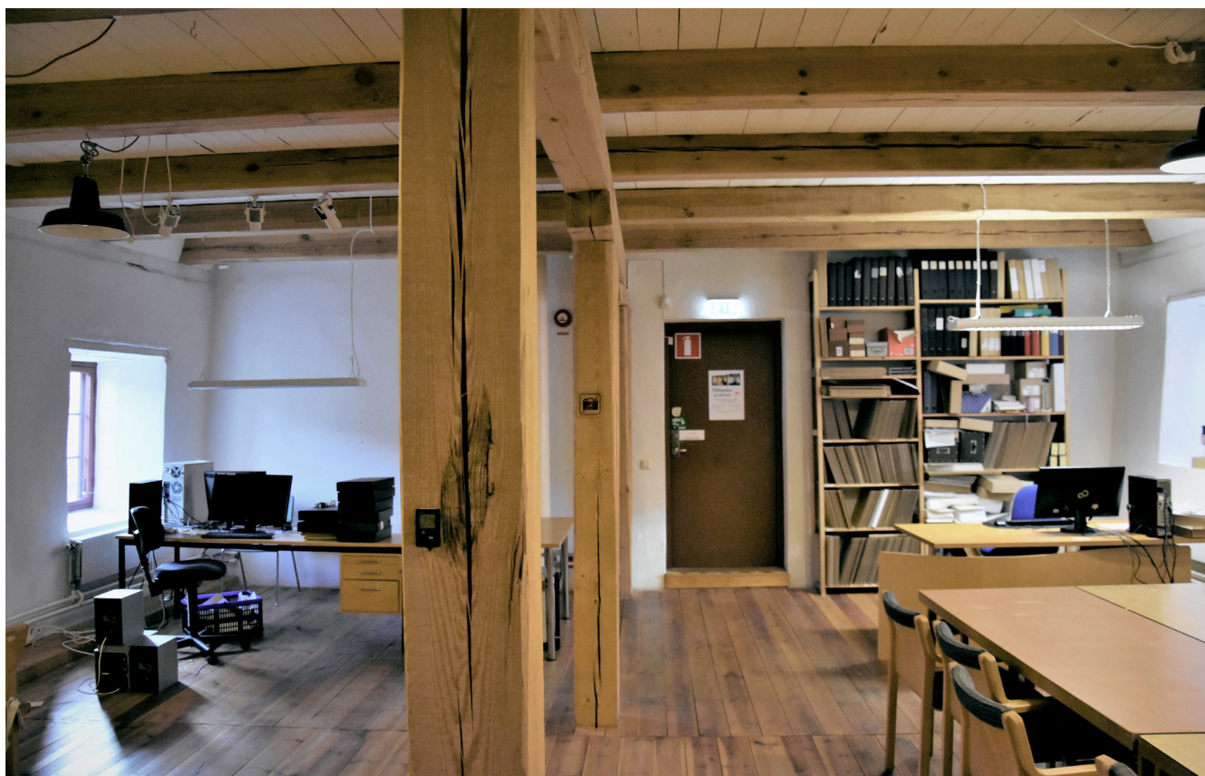
Hinder. Flera bjälkar i lokalen sätter en prägel, men blir också en fara för synskadade och bör markeras med avvikande färg, menar man från Varbergs kommuns handikappråd – tillgänglighetsgruppens referensgrupp.
