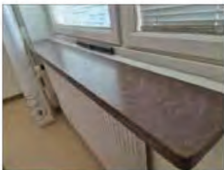
• Fönsterbänkar av sten.
