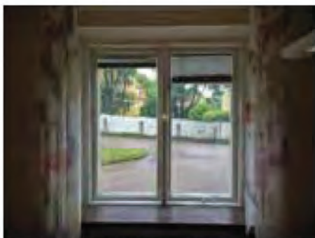
• Äldre tvåglasfönster av trä och fönsterbänkar av sten.
