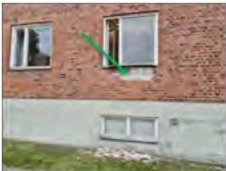
✓ Cellplastisolering bakom tegel. Ej freon.
