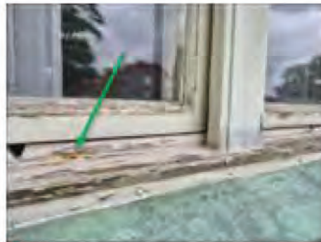
✓ V:2. Nedan fönster. På träkarm. Kitt vitt hårt. Ej asbest.
