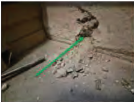
✓ 09011:2. Betong, yttervägg. Samtliga analyserade metaller i halter under KM.
