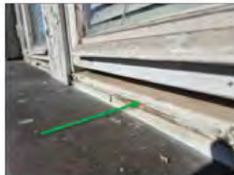
✓ Ö:11. Underkant fönster. Fönsterkarm/plåt. Färg/kitt. Vitt/grått. Ej asbest.
