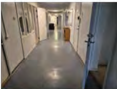
✖ Exempelbild golvplastmatta by 112 plan 12. Antas innehålla mjukgörare så som prov 10017:1 och 11002:1. Hanteras som farligt avfall om inte kompletterande provtagning visar annat.
