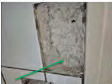
✓ 10027:2 + 10025:1. Vitt kakel. Fix & fog. Ej asbest.
