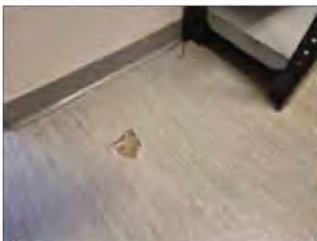
✓ 10044:1. Golvplastmatta grönstrimmig + mörkbrunt lim. Ej asbest.
