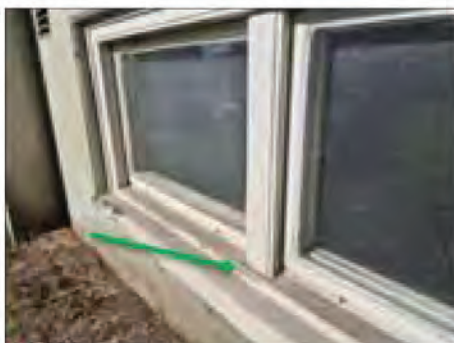
✓ Ö:12. Underkant fönster. Fönsterkarm/plåt. Kitt grått tunt. Ej asbest.
