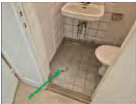
✓ 09006:1. Fix och fog vid gråspräckligt klinker. Ej asbest.
