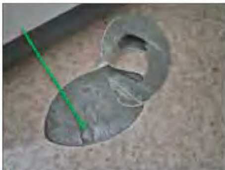
✓ 12028:1. Brunt lim + ytbetong dolt under golvplastmatta med beigt lim. Ej asbest.
