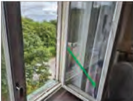
✓ Ö:10. Fönster. Kitt vitt hårt. Ej asbest.
