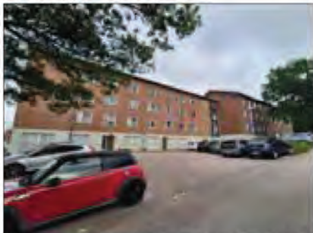
Översiktsbild by 111 och 112 Norrebo. Fasader åt öst.
