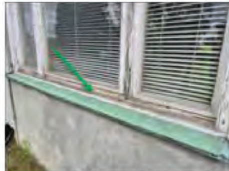
✓ S:1. Nedan fönster. På träkarm. Kitt ljusgrått sprött. Ej asbest.
