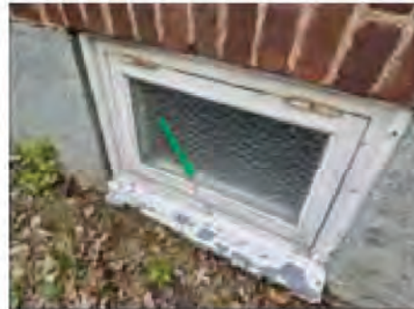
✓ Ö:9. Fönster. Kitt vitt hårt. Ej asbest.
