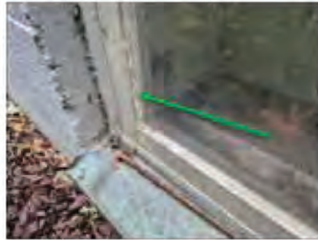
✓ N:3. Fönster. Kitt beige hårt. Ej asbest.
