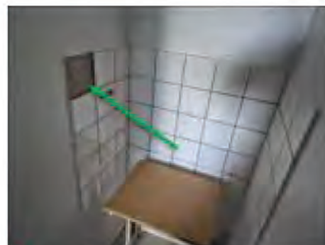
✓ 12029:1. Fix och fog vid vitt kakel. Ej asbest.
