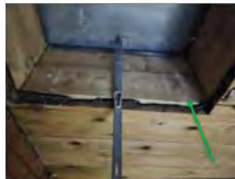
✓ Vind Takpapp andra lagret. Vid taklucka. Ej PAH.
