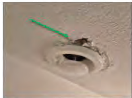
✓ 09006:3. Tätning kring vent.don. Grå + vit. Ej asbest.
