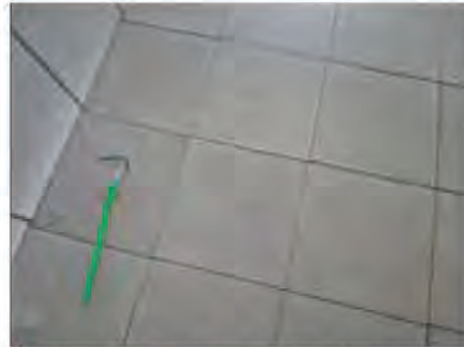
✓ 09008:1 Fix och fog vid beige klinker. Ej asbest.
