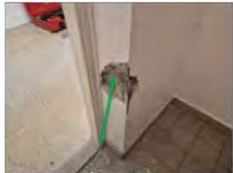
✓ 09007:2. Puts innervägg. Ej asbest
