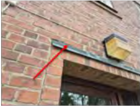
✗ V:1. Ovan droppbleck. Mot tegel. Fog ljusgrå seg/porös. Innehåller asbest. Ej PCB. Ej Klorparaffiner.
