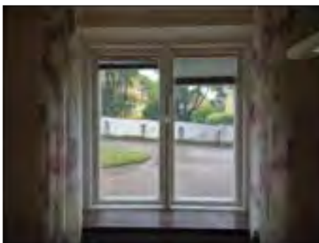
By 111 och 112. Övervägande består fönster av äldre träfönster.
