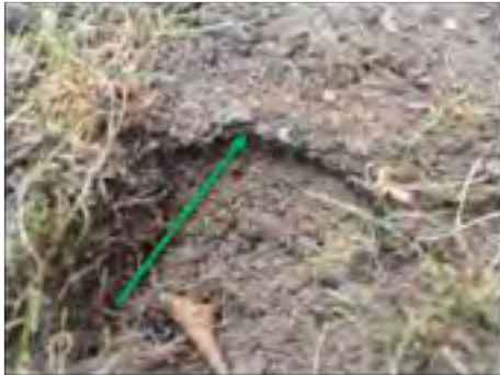
✓ Mark:2. Asfalt. Ej PAH.
