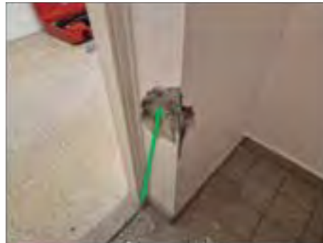
✓ 09007:2. Puts innervägg. Ej asbest
