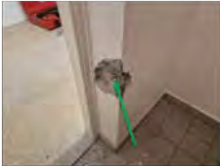
✓ 09007:1. Betong mellanvägg. Alla analyserade metaller har halt under KM.
