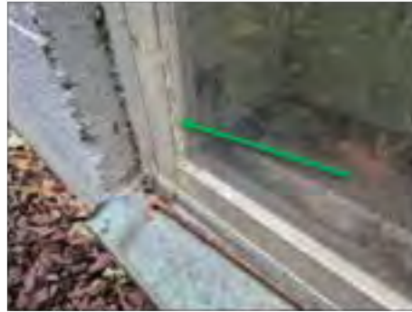
✓ N:3. Fönster. Kitt beige hårt. Ej asbest.
