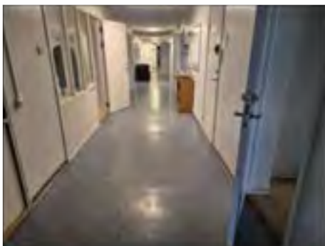
✖ Exempelbild golvplastmatta by 112 plan 12. Antas innehålla mjukgörare så som prov 10017:1 och 11002:1. Hanteras som farligt avfall om inte kompletterande provtagning visar annat.
