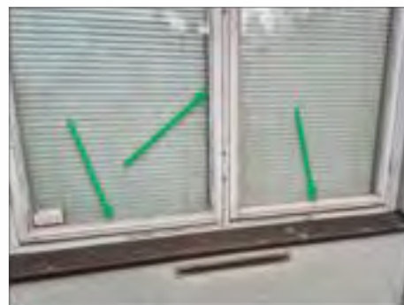
✓ Ö:5. Fönster. Kitt vitt hårt. Ej asbest.
