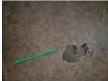
✓ 10017:1. Golvplastmatta brun och gråmelerad, mörk. Innehåller inga ftalater, klorparaffiner eller metaller över gränsen för farligt avfall.
