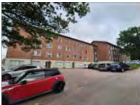
Översiktsbild by 111 och 112 Norrebo. Fasader åt öst.
