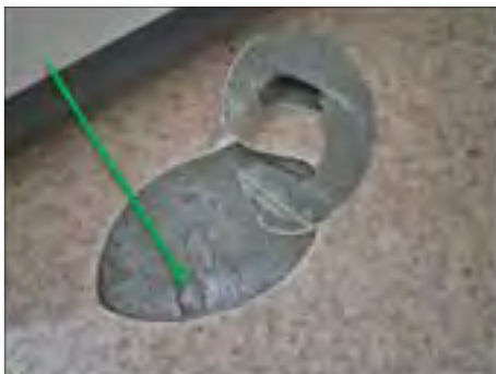
✓ 12028:1. Brunt lim + ytbetong dolt under golvplastmatta med beiget lim. Ej asbest.
