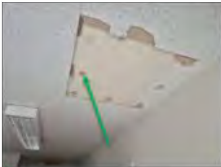
✓ 12002:1. Punktlim under akustikplatta. Lim gulbrunt. Ej asbest.
