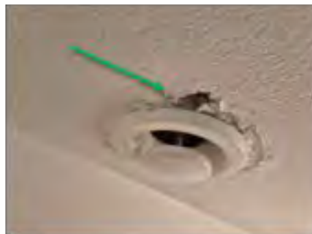
✓ 09006:3. Tätning kring vent.don. Grå + vit. Ej asbest.
