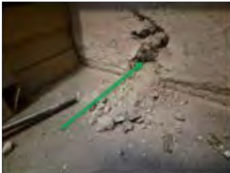
✓ 09011:2. Betong, yttervägg. Samtliga analyserade metaller i halter under KM.
