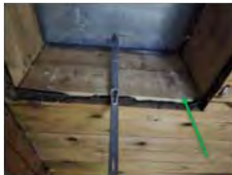
✓ Vind Takpapp andra lagret. Vid taklucka. Ej PAH.
