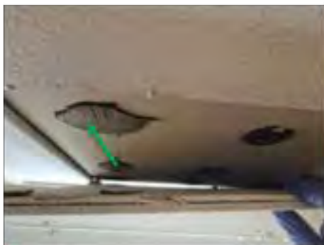
✓ 09004:1. Punktlím under äldre akustikplatta. Lim mörkbrunt. Ej asbest.
