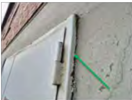
✓ Ö:4. Runt dörr. Bruk. Ej asbest.
