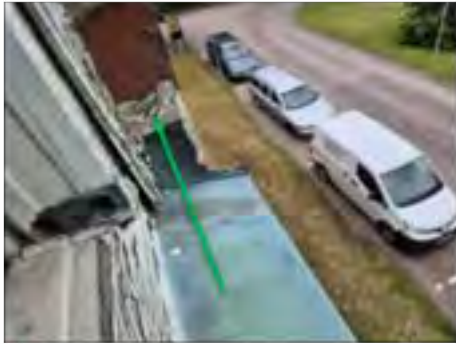
✓ S:4. Vid fönster. Bleck/tegel. Fog beige mjuk. Bly halt: 16,3 mg/kg. Ej asbest. Ej PCB. Ej klorparaffiner.
