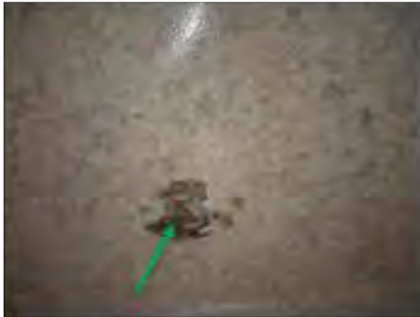
✓ 11031:2 Svartlim under synlig golvplastmatta. Ej asbest.
