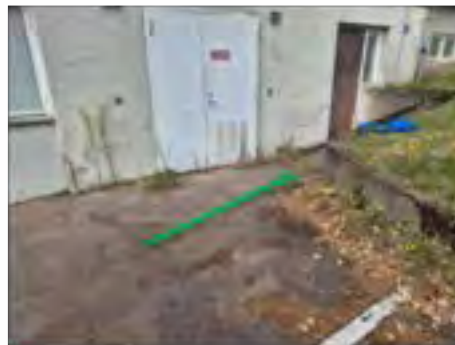
✓ Mark:1. Asfalt. Ej PAH.
