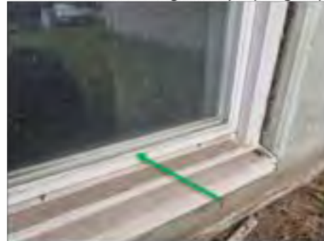
✓ Ö:3. Fönster. Kitt vitt hårt. Ej asbest
