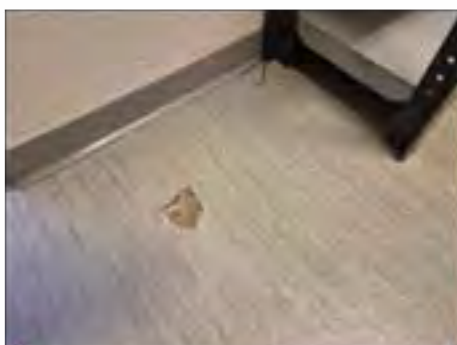
✓ 10044:1. Golvplastmatta grönstrimmig + mörkbrunt lim. Ej asbest.
