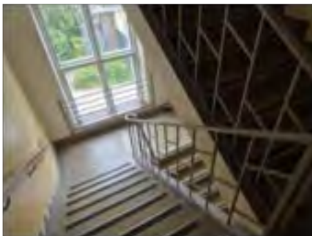
By 111 översiktsbild trapphus.
