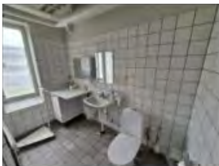
På grund av pågående verksamhet har provtagning och håltagning varit begränsad i delar av byggnaderna. Kompletterande provtagning behöver utföras i dessa utrymmen med avseende på eventuella dolda material. Även befintliga ytskikt kan behöva provtas i dessa utrymmen i viss mån, exempelvis fix och fog vid kakel och klinker. Mindre utrymmen så som wc 'n behöver undersökas med avseende på asbest i eventuell avjämningsmassa.
